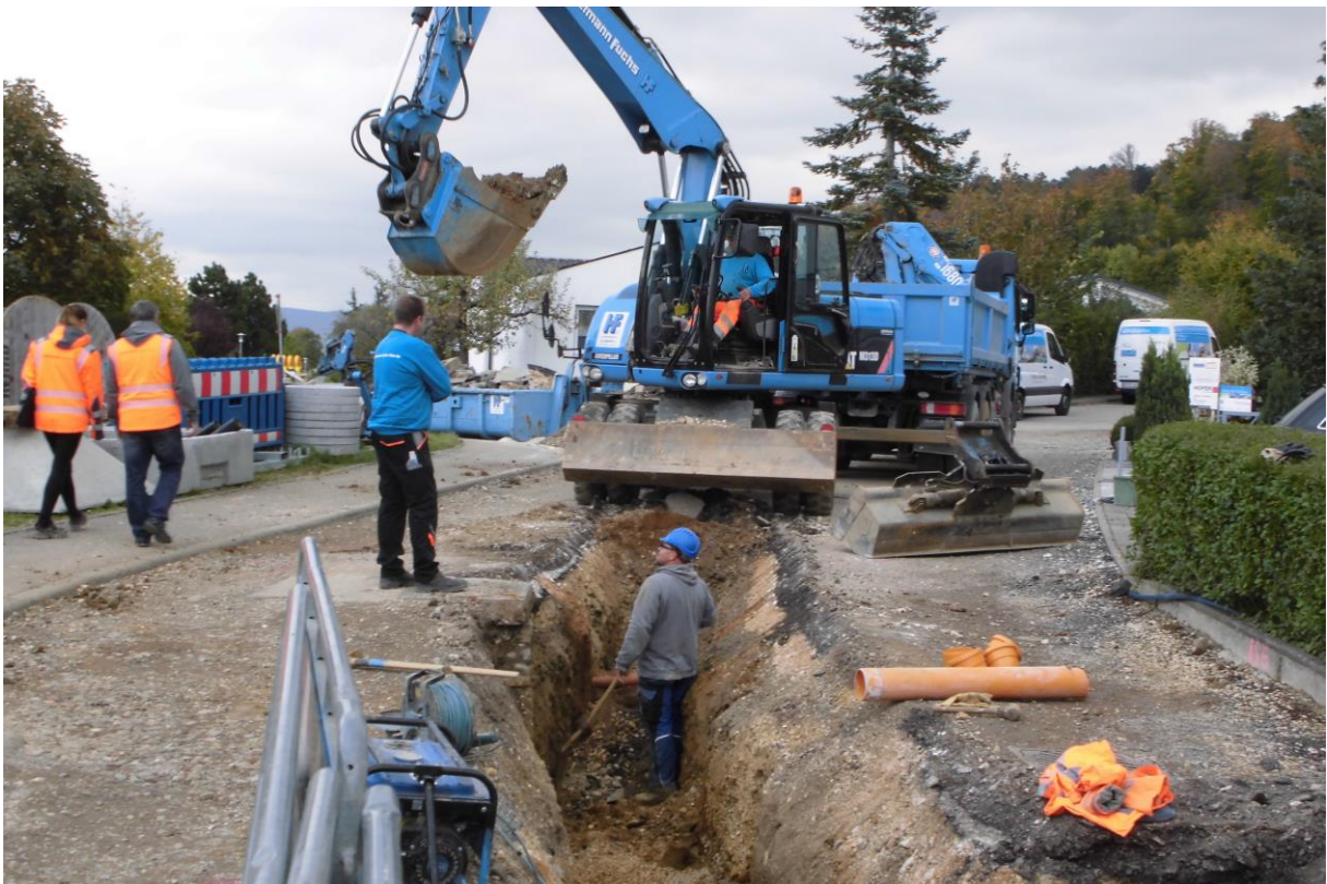
Theußenbergweg: Ausführung der Leitungsbauarbeiten
